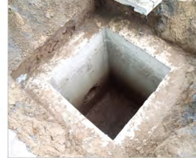
① 상부 슬래브 제거
