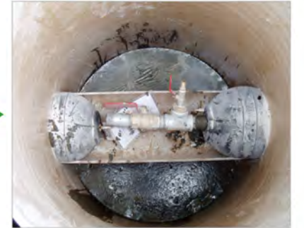
⑥ 충전제 타설(인버터 설치)
